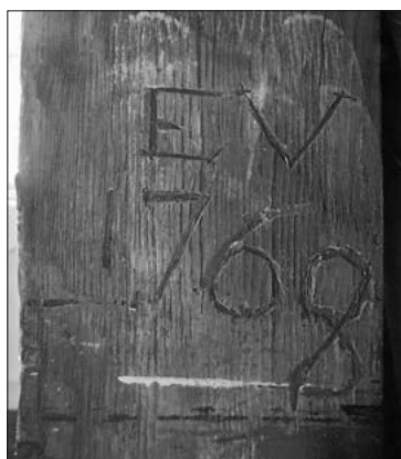
Het merkteken EV 1768 op het korbeel in de oostelijke zolder. Foto J. Morren 2017.
