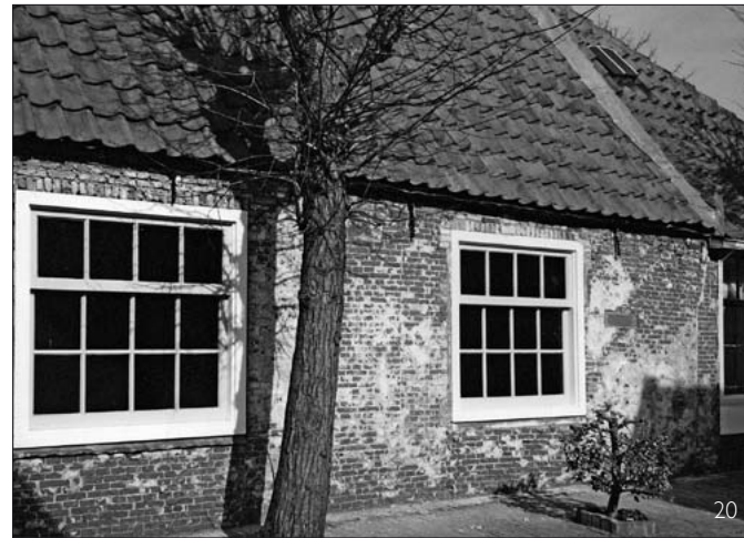
20 De zuidgevel tijdens de restauratie. Tussen de twee vensters is in het metselwerk duidelijk een van de naden te zien van de dichtgemetselde deuropening.
