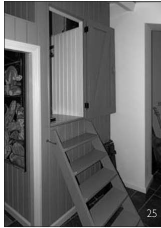
25 De kraalschot wand in het oostelijk deel met de deuropening en de trap naar de zolderverdieping. Foto J. Morren 2016.
