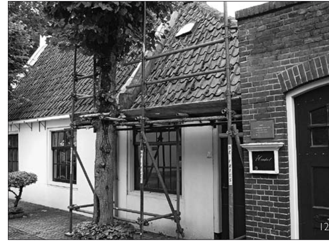
12 De restauratie van het oostelijk deel. Rechts het cachot, achter de WC aangebracht.
