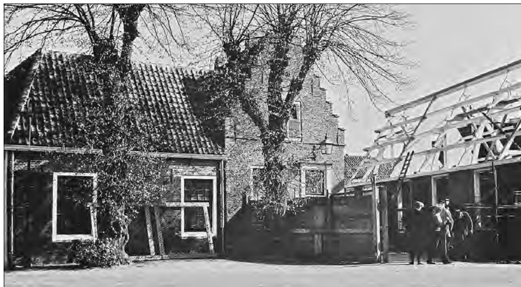
Afbeelding 10. De zuidgevel van de panden Torenstraat 4 en 6 in 1966. Foto: beeldbank Noord-Hollands Archief, Haarlem. KNA001002503.
