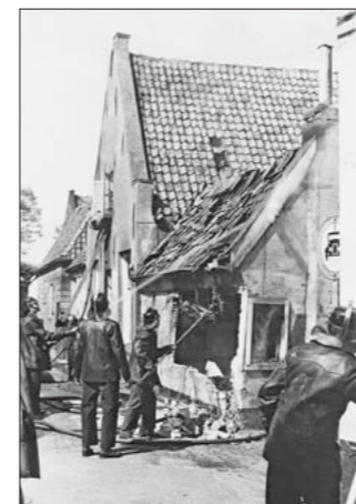
Het huis na de explosie en de brand in de zuidelijke uitbouw. De brandweer is aan het nablussen en trekt de op instorten staande delen omver. Noord-Hollands Archief, de Beeldbank, KNA001008414.
