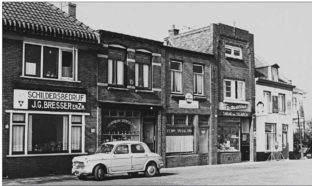
9. Links het pand naast het schouthuis dat in 1936 is gebouwd op de plaats van het gesloopte noordelijk deel van het Schouthuis. Foto Noord-Hollands Archief, de beeldbank KNA001002028.
