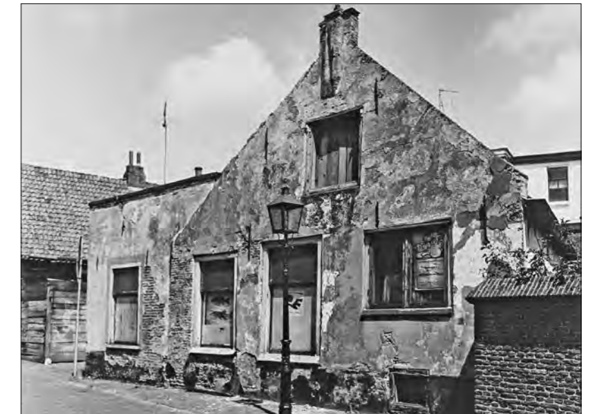
Afbeelding 18 Het huis van de metselaar in vervallen toestand voor de restauratie in 1972. Foto: Noord-Hollands Archief, foto nr. KNA001002171.
