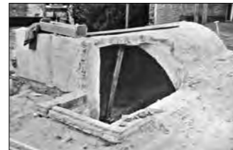
Afbeelding 19 Het tongewelf van de kelder na de sloop van het huis van de metselaar in 1972.
