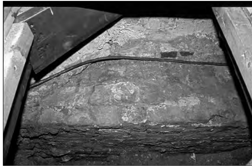
005 De fundatie die van het herbouwde huis zal zijn, dat later de naam 's Gravenlust kreeg. Foto J. Morren, 2000.
